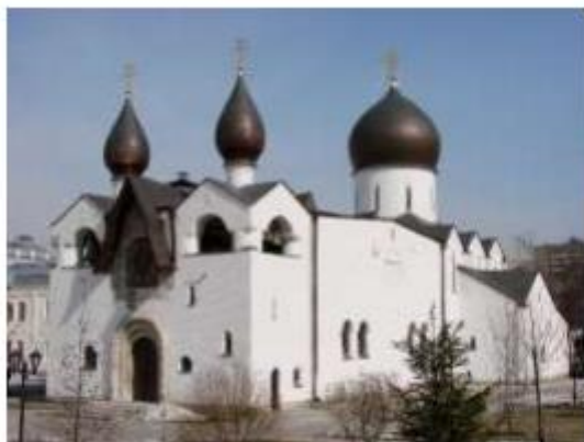
Вид с северо-запада
