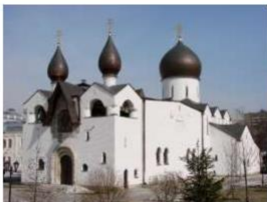
Вид с северо-запада
